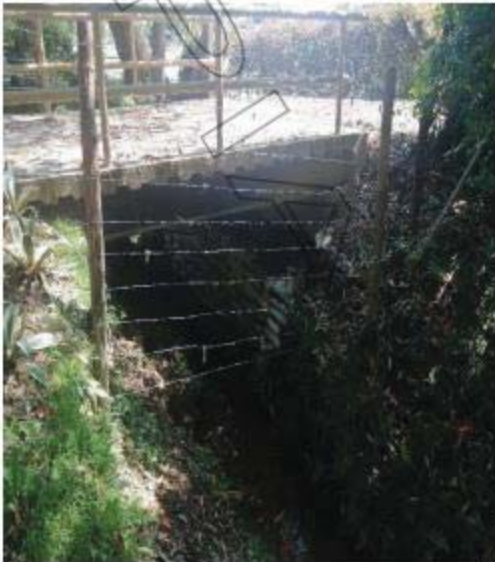
Imagen No 2. Trinchos en tierra y costales y cerramiento en alambre de púas a ambos costados
