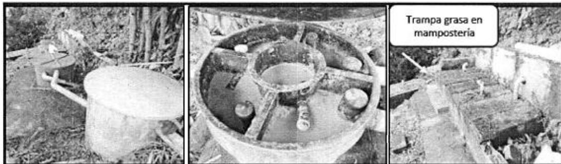
**Imagen 2.** Cornare. 2021. Trampas de grasa utilizadas como pretratamiento del agua residual procedente de la zona de cocina del restaurante.
