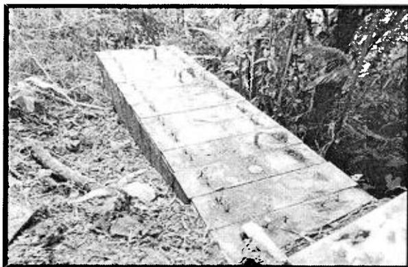
**Imagen 1.** Cornare. 2021. Tanque séptico del STARD del restaurante.
