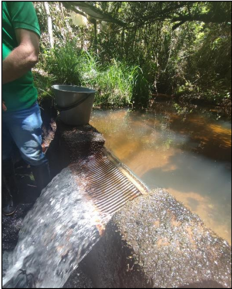
Figura 1. Lugar de la captación con rejilla para el control de caudal
