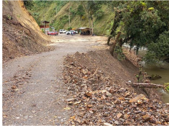
Material dispuesto sobre área de protección
