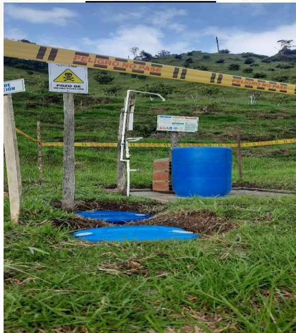
Pozo de desactivación y sistema de almacenamiento
