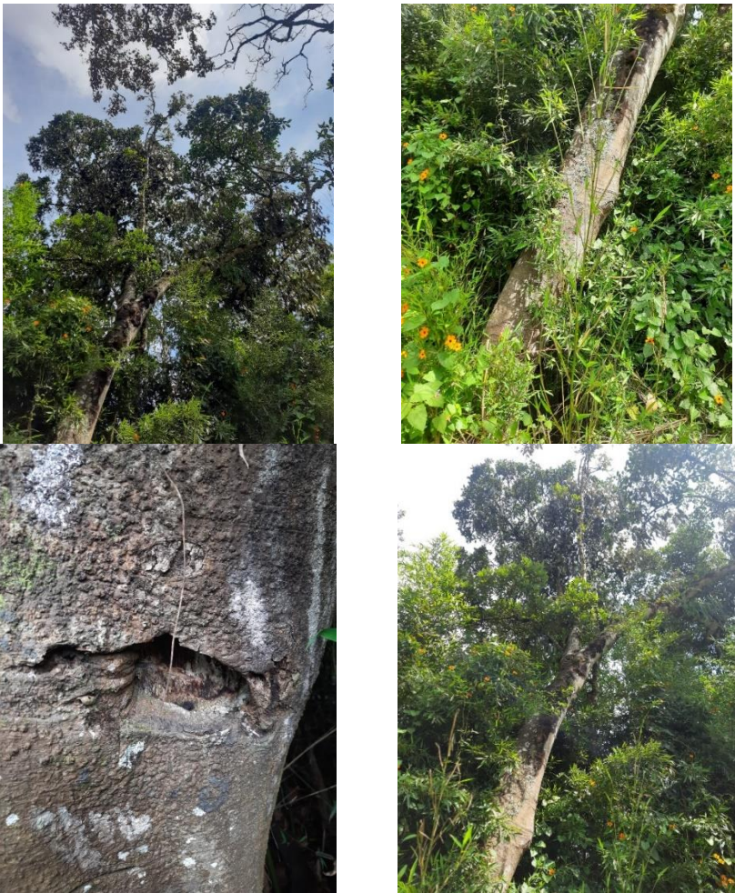
Imágenes correspondientes a las condiciones fitosanitarias y estructurales de los arboles
