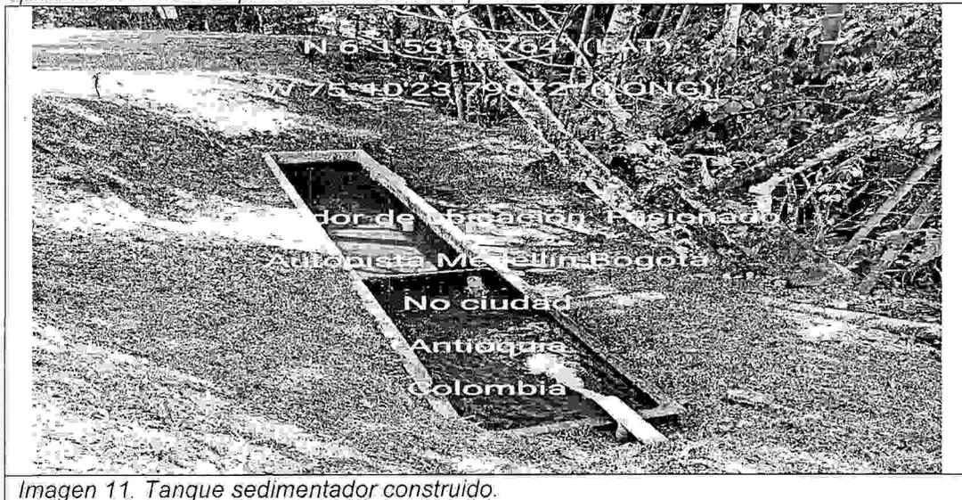
Imagen 11. Tanque sedimentador construido.
