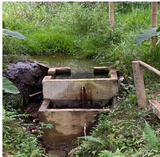
Imagen 1. Obra fuente Arrayanes Captación 2
