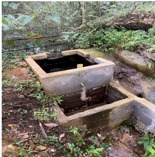
Imagen 2. Obra fuente Nueva
