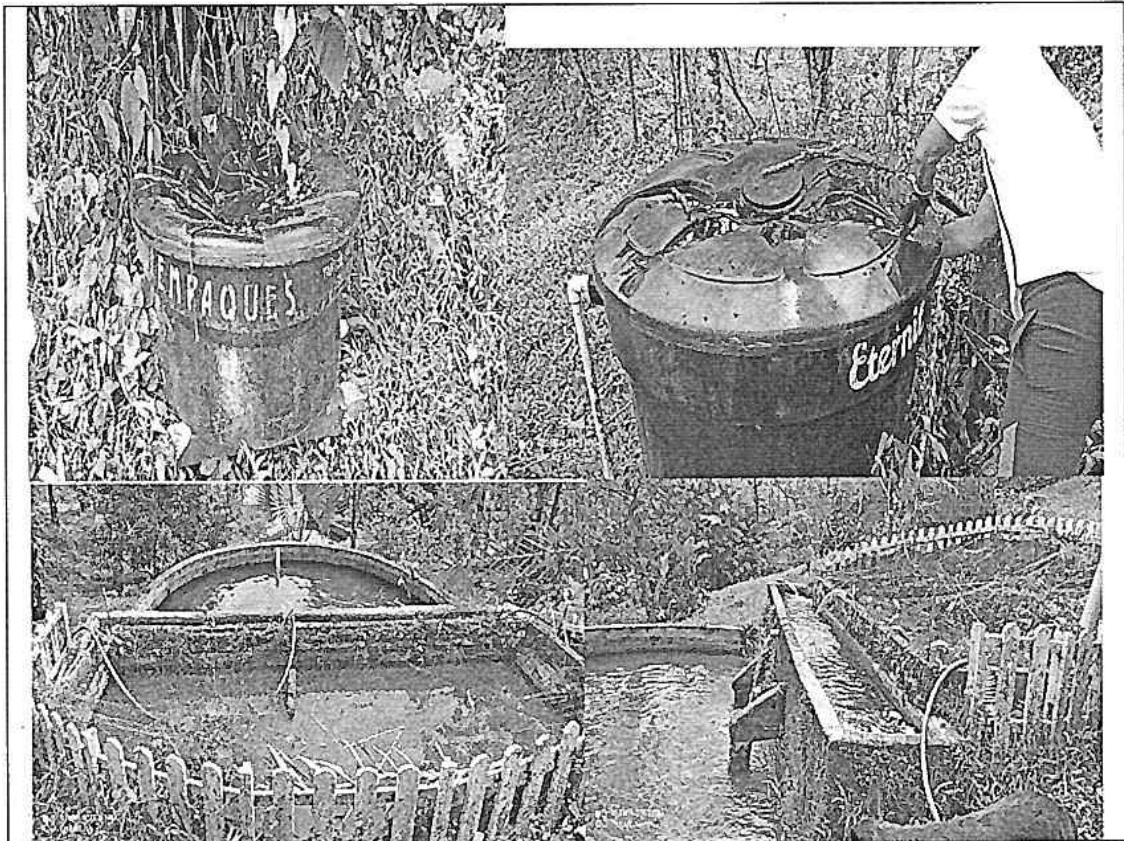
Imagen 2,3, 4 y 5 : Tanques de almacenamiento para uso domestico y estanque piscicola, del cual, lo abastecen del tubo de rebose del tanque de almacenamiento de 1000Lt.
