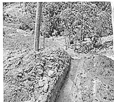
Fotografía 3. Canaletas construidas en los laterales de la infraestructura.
