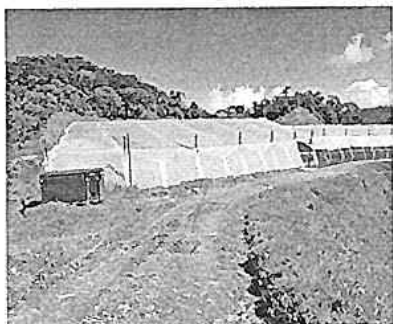
Fotografía 1. Infraestructura tipo invernadero, encontrada en el predio con FMI:018-163148
