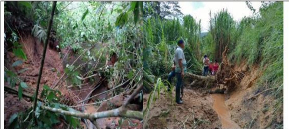
Se observa uno de los deslizamientos y palizadas ocurridas dentro del cauce de la fuente.
