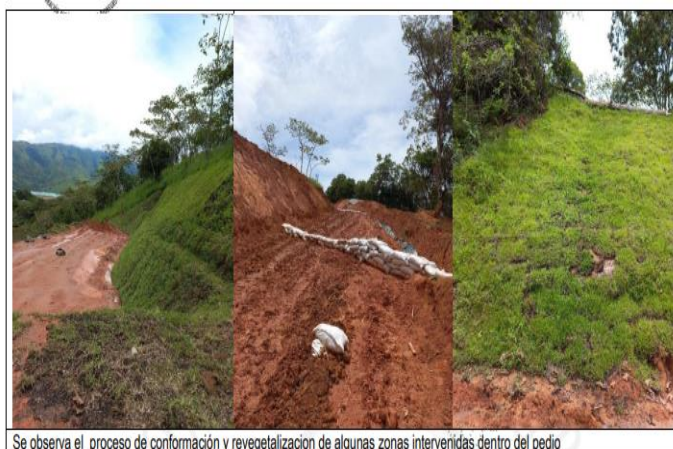
Se observa el proceso de conformación y revegetalización de algunas zonas intervenidas dentro del predio
