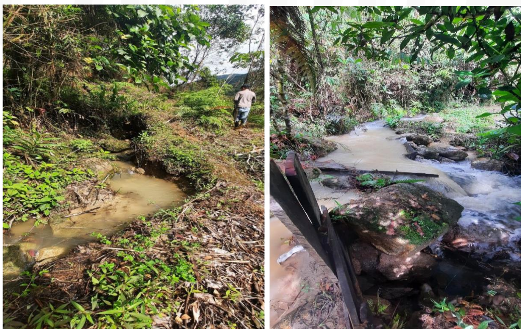
Acequia con flujo continuo Captación Rudimentaria
