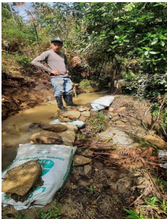
Sitio donde se implementó un sistema rudimentario de retención del agua por la acequia y evidencia del proceso erosivo en el lugar
