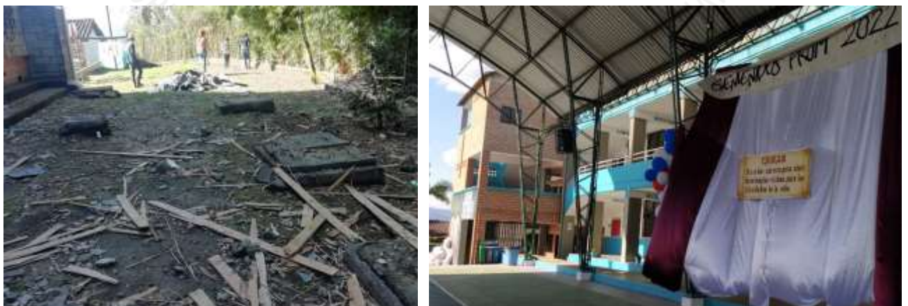
Imágenes de las instalaciones en funcionamiento de la Institución Educativa San José de las Cuchillas.
