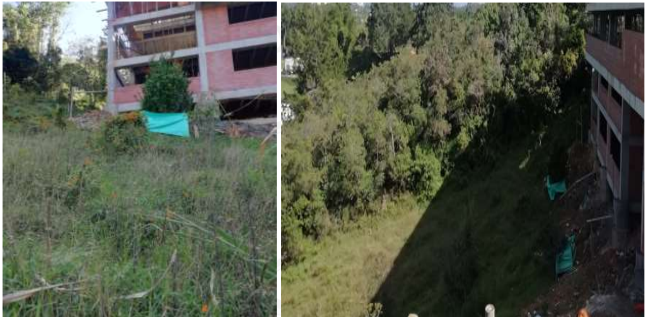
Imágenes del punto donde se va a instalar la el sistema de tratamiento de aguas residuales.
