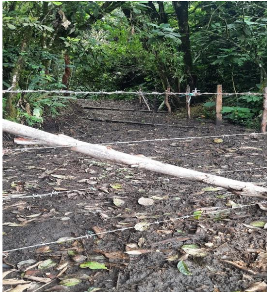
Inicio de la apertura de vía, al costado derecho pasa la fuente hídrica
