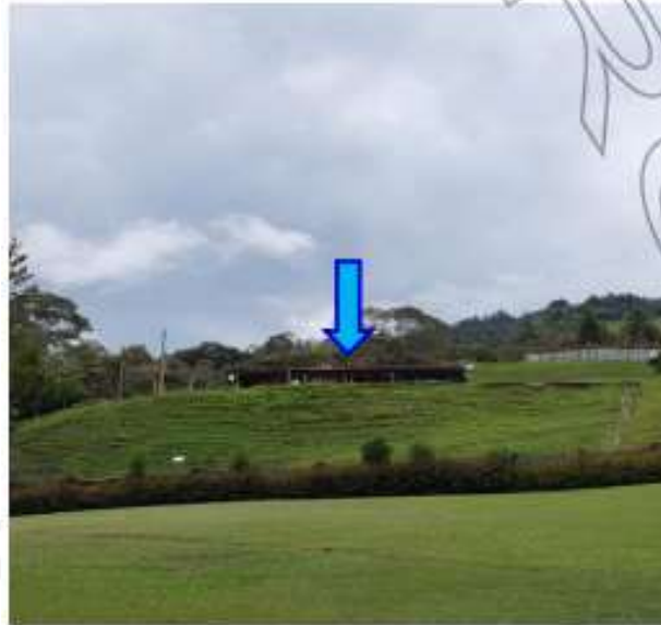
Figura 1. Predio en el que se encuentra el tanque de almacenamiento
