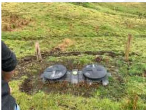
Foto 1. STARD prefabricado de 2000 l – Porcicola La Unión
