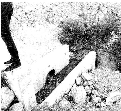
Imagen No 3 Descarga de Aguas Residuales a Box Couvert.
