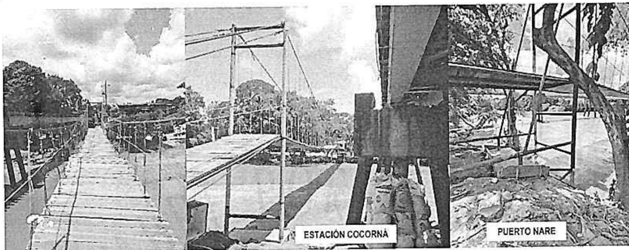
Imágenes 3. Estructura del puente colgante artesanal al lado de la línea férrea.
