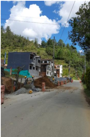
Imagen 3: Frente de obra y avance general.
