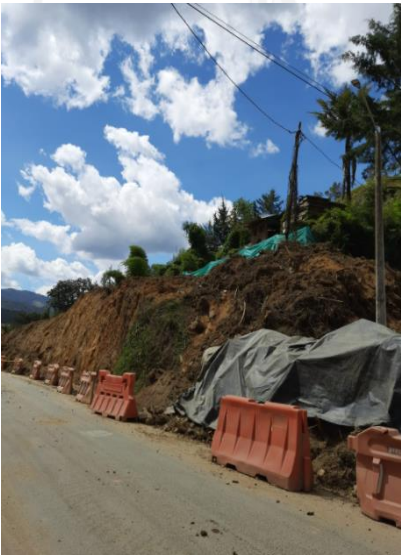
Imagen 1: Predio 017-24057 donde se encontraban los 3 árboles.
