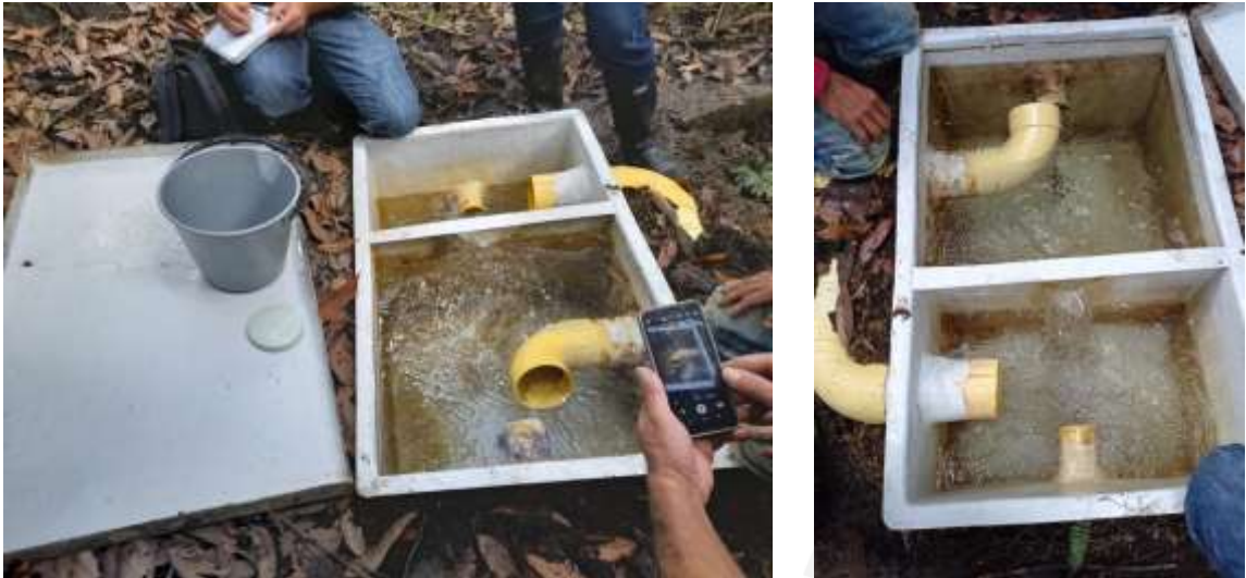
Ilustración 3. Obra de captación
