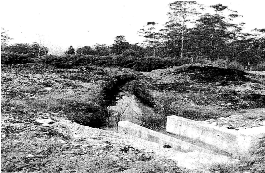
Fotografía No 1- Retiro de material de lleno parcial, aún no se recupera la fuente hídrica
