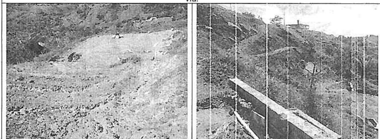
Imágenes 19 y 20. Corte de taludes con alturas superiores a 3 metros de altura, que por falta de obras drenaje arrastra sedimentos a las fuentes cercanas.
