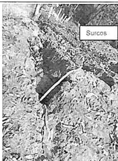
Foto 4. Surcos conformados por aguas de escorrentia superficial del talud.
