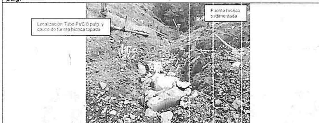
Foto 9: Localización de la salida del tubo de PVC de 8 pulg. y visualización de Fuente hídrica
