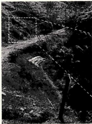
➤ Se instalaron unos bolsacretos, como medida de mitigación al problema erosivo presente en la vía.
