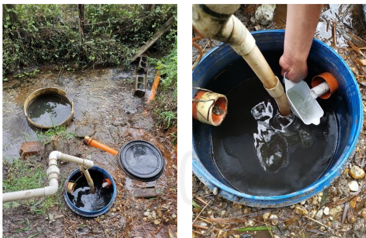
Figura 1. Obra de captación
