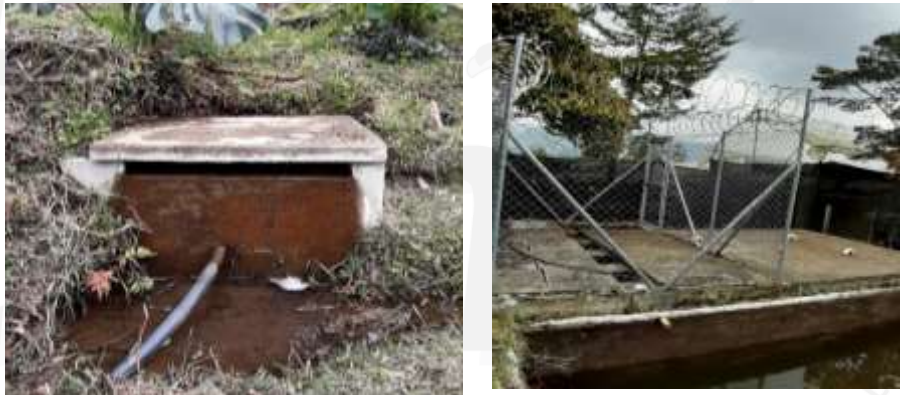
Figura 4. Tanque donde se unen las aguas del Ramal 1 y 2.
