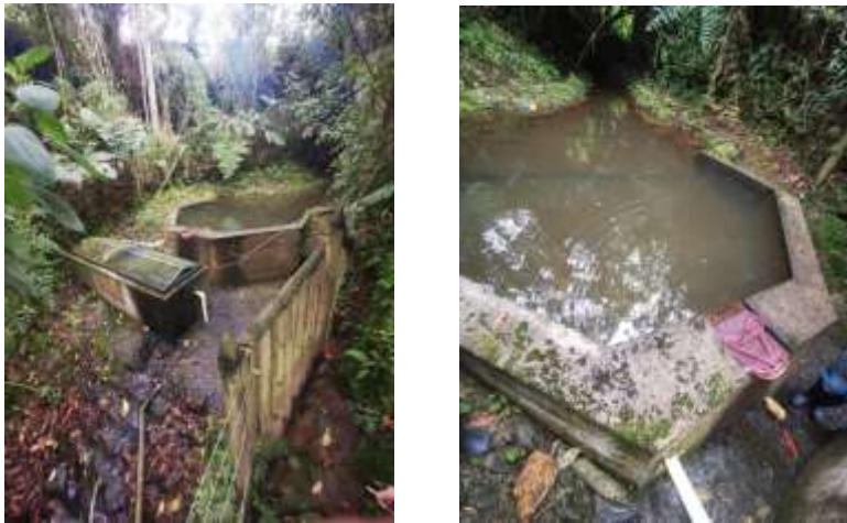
Imagen 6 y 7: Punto de captación 2 de la fuente FSN1.
