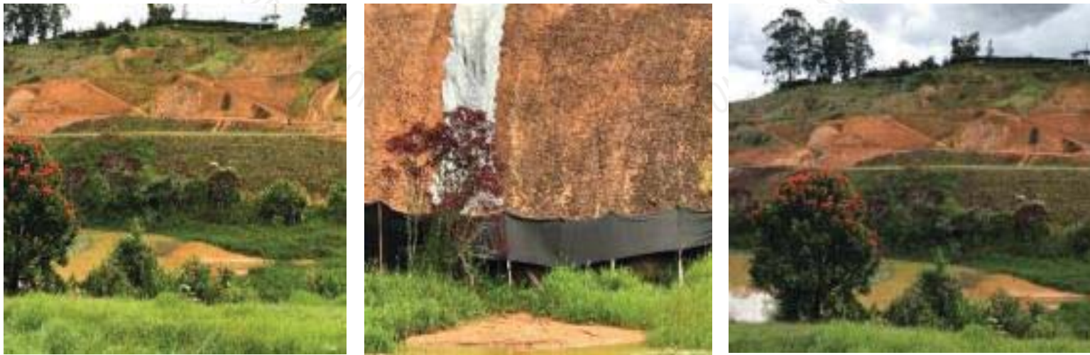
Fotografías 1, 2 y 3. Ejecución del proyecto Fuente. Informe técnico N° 03130-2021
