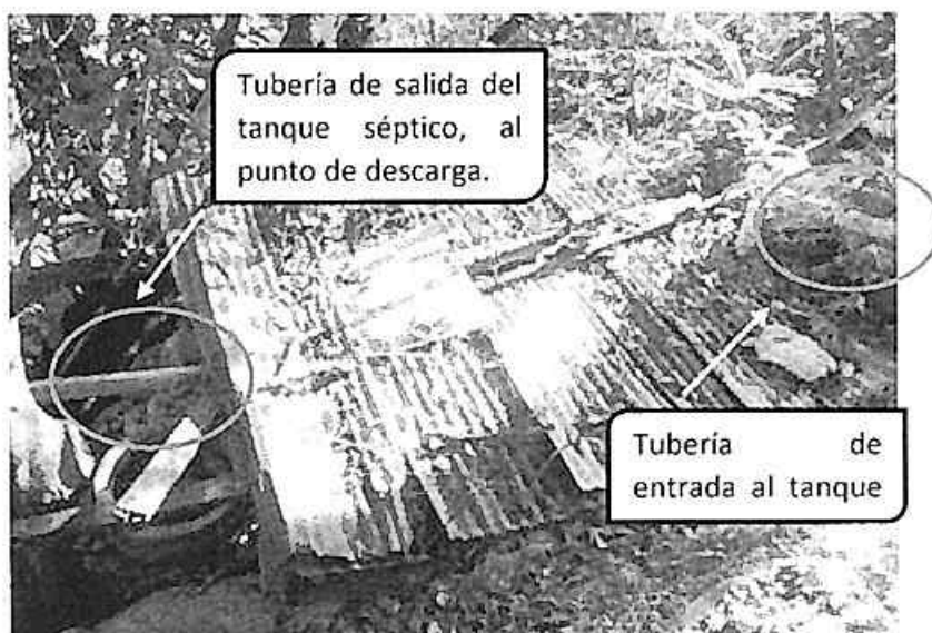
Imagen 5. Tanque séptico integrado cubierto con láminas de zinc para su protección. Fuente Cornare 2021.
