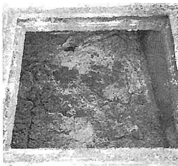
Imagen 6. Trampa grasa utilizada como unidad de pretratamiento del agua residual procedente de la zona de restaurante. Fuente Cornare 2021.
