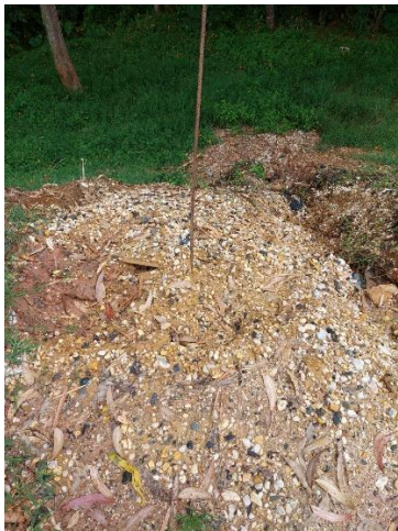
Figura 1. Sellamiento del aljibe que no se encontraba en uso
