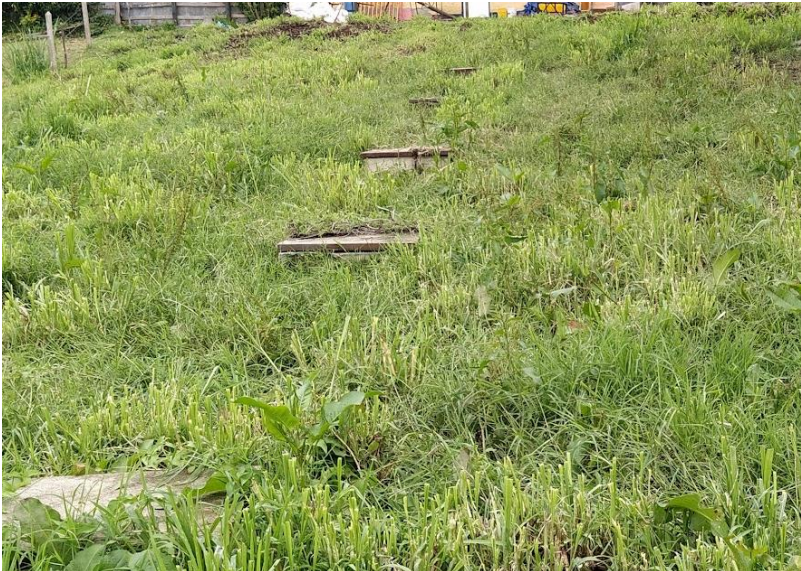
Foto No 3: Campo de infiltración implementado y en funcionamiento
