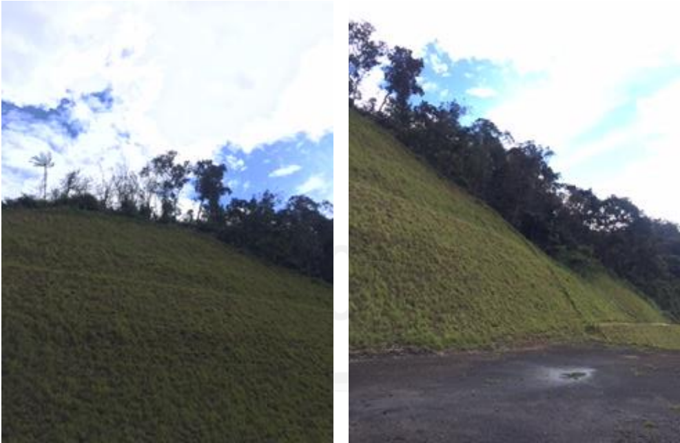
IMAGEN 1 Y 2 ZONA DE INTERVENCIÓN
