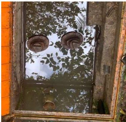
Imagen 14. Macromedidor de salida Fuente. Jhon Jaramillo Tamayo
