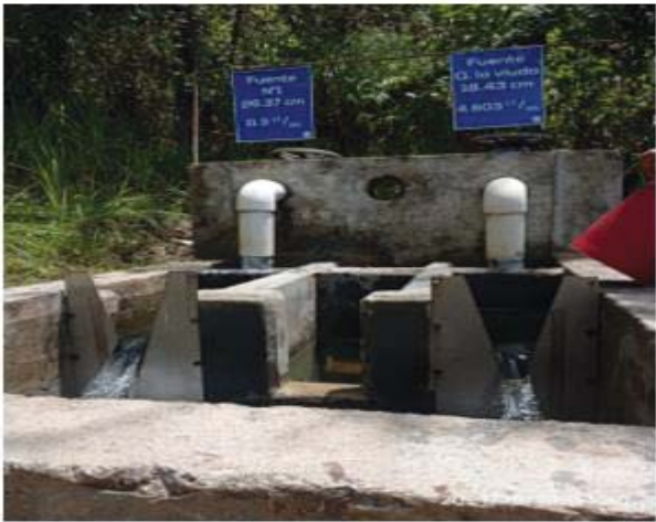
Figura 1. Obras de captación de las Fuentes #1 y #3 (Quebrada la Viuda).
