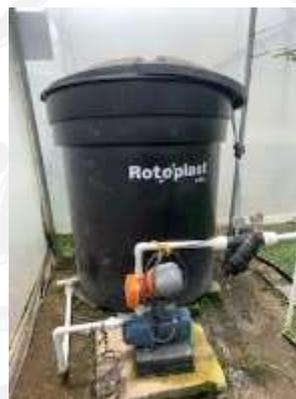
Fotografía 5. Tanque de almacenamiento efluente STARNd
