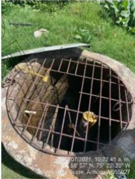
Ilustración 5. Tanque almacenamiento en concreto
