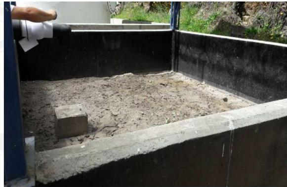
Foto 4. Adecuación placa en concreto lechos de secado
