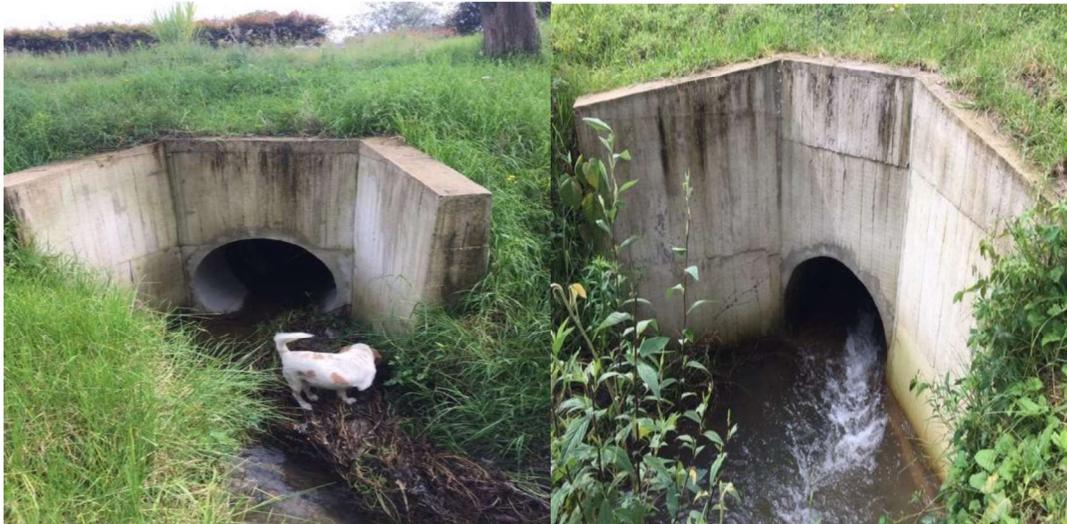
Fotos 1 y 2 : Entrada y salida de obra hidráulica con tubería de 36 “
