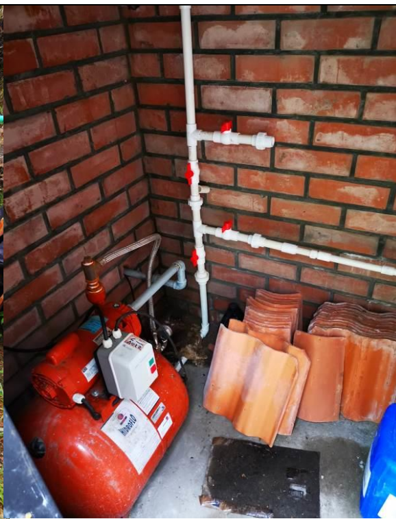
Imagen 3. Sistema de bombeo implementado por el señor Fernando León a partir del tanque, de este le suministra agua a la señora Bertha Castaño.
