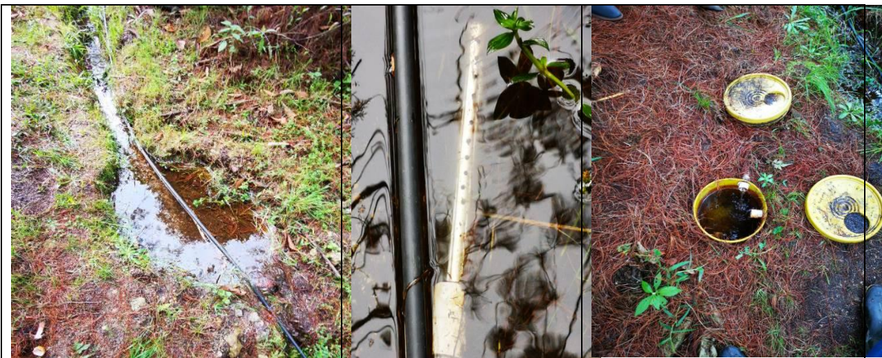
Imagen 1. Obra de captación del señor Nicolás Arango
