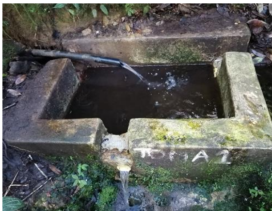
Imagen 1. tanque en concreto
