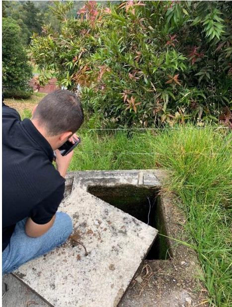
Imagen 3. Tanque de almacenamiento
