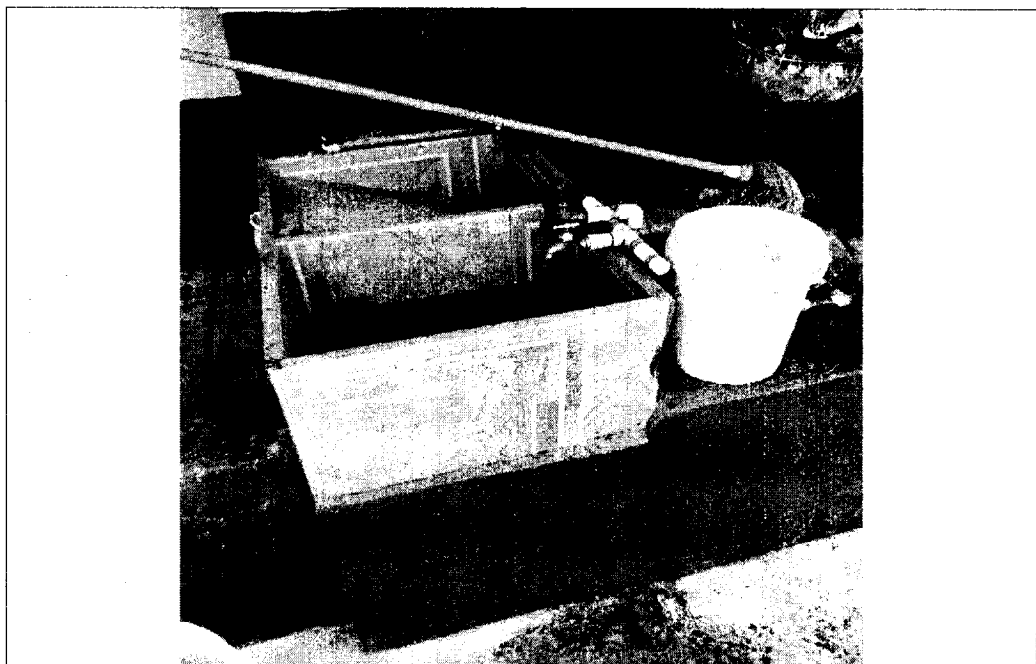
Imagen 1. Válvulas para el control de flujo proveniente de la obra de captación conjunta.
