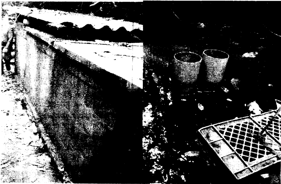
Bocatoma y tanque Bocatoma y tanque de succión
