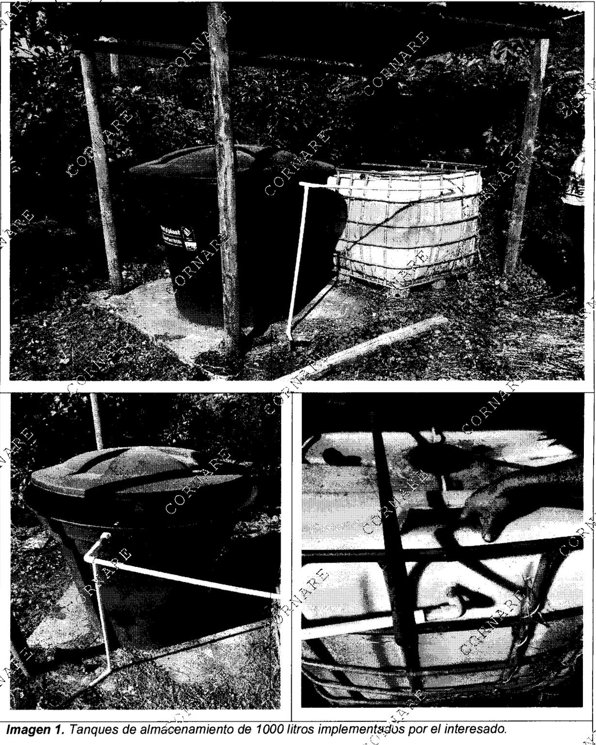
**Imagen 1.** Tanques de almacenamiento de 1000 litros implementados por el interesado.
