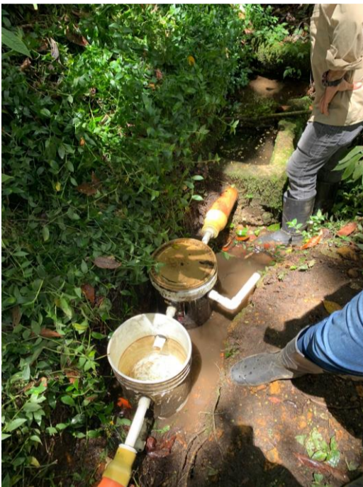
Ilustración 1. Obra de captación y control de caudal
