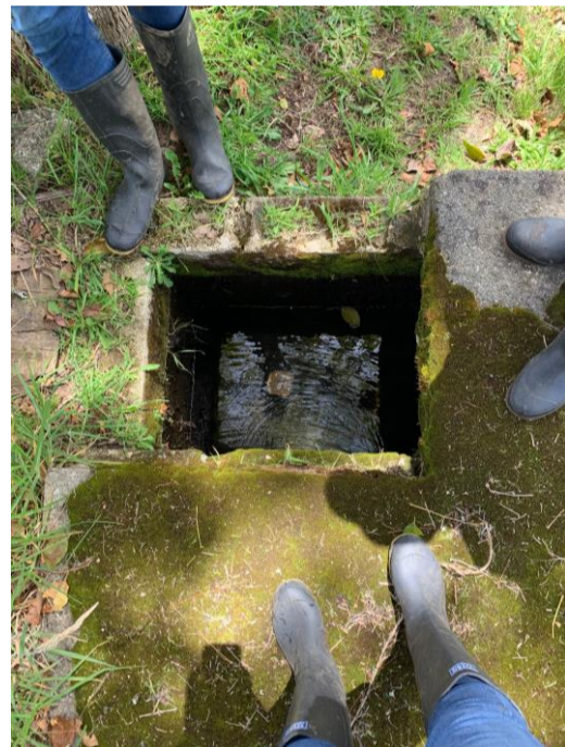
Ilustración 2. Tanque de almacenamiento
