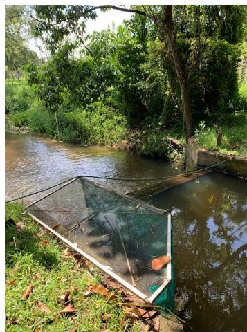
Ilustración 1. Obra de captación Q. La Enea
