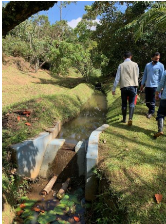
Ilustración 2. Obra de captación Q. La Noreña
