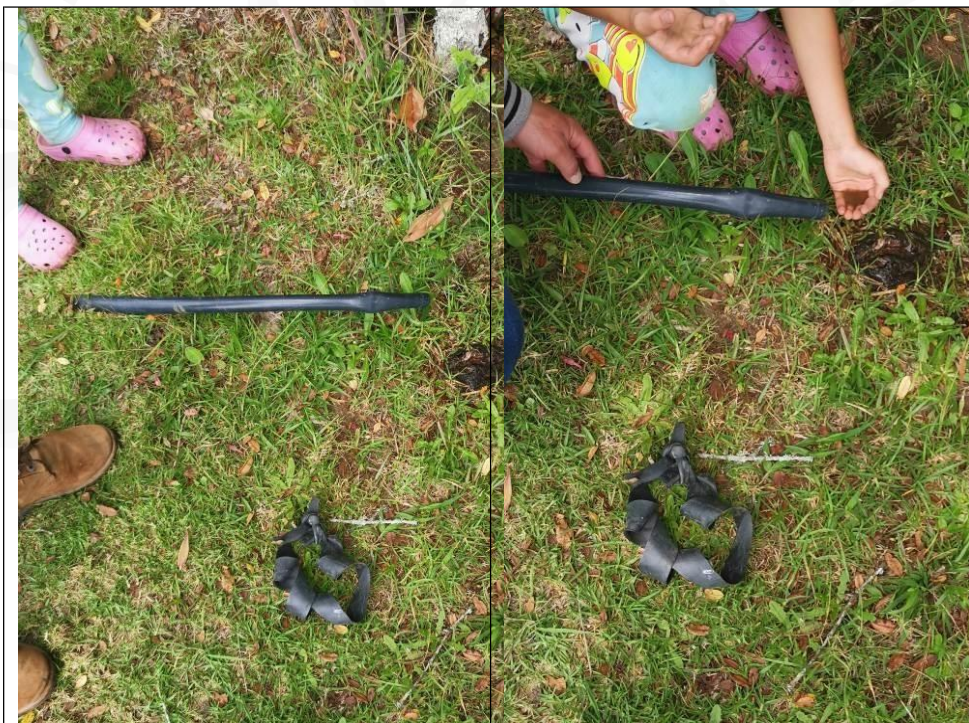
Imagen 1 y 2. Estado del suministro de agua al predio del señor José Rodrigo López, el día de la visita, caudal derivado de la fuente El Guadual.
