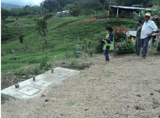
Ilustración 3. Sistema de tratamiento de aguas residuales domésticas
