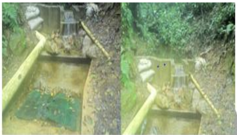
Imágenes 4 y 5: Captación en el Afluente Izquierdo. Tanque de almacenamiento Fotos tomadas de presentación de Cornare.
