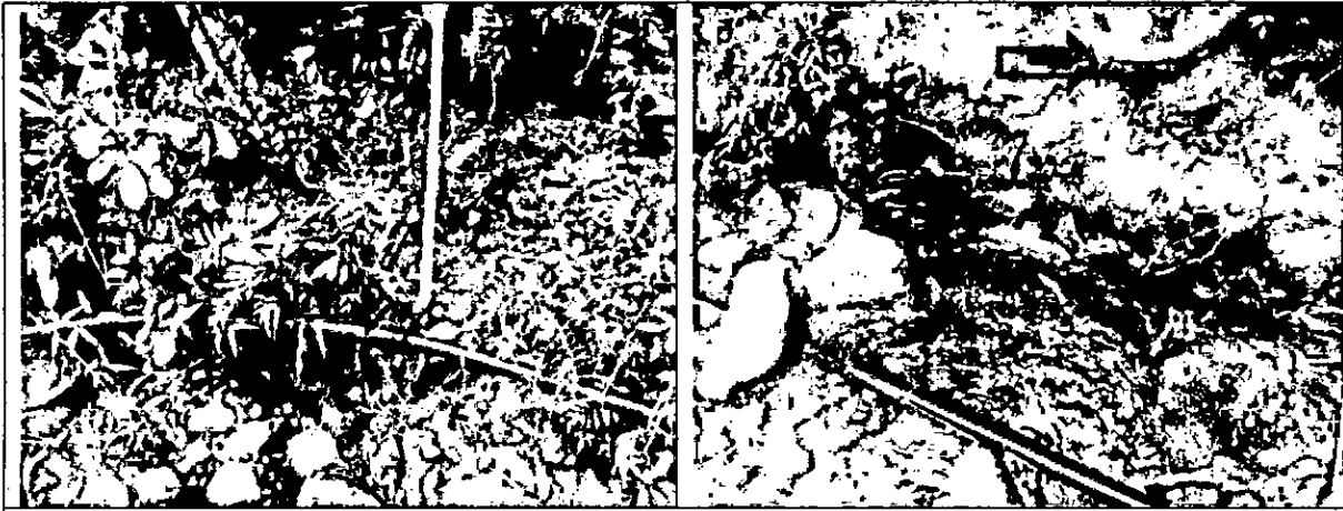
Foto 5. Aseguramiento de manguera a arbustos y raíces.
